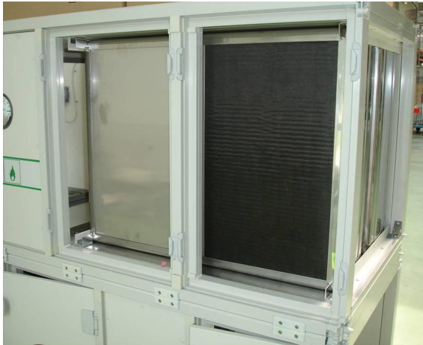
Foto 8: Ansicht Schalldämpfer Modul (Zuluft), seitliche Bedienpaneele demontiert, Zwischenholm montiert.
