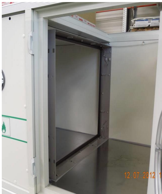
Foto 12: Filterkammer Abluft Innenansicht
